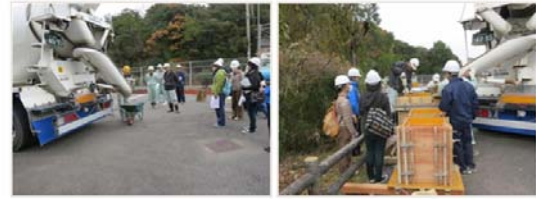
写真、基礎コンクリート打設工事及びコンクリート品質検査の様子
