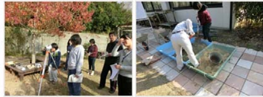
写真、レンガ舗装施工の様子
