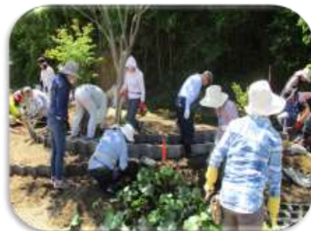
緑地施工実習
