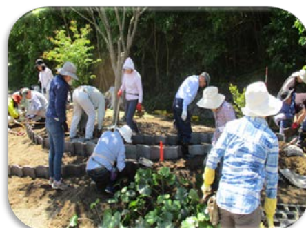
緑地施工実習
