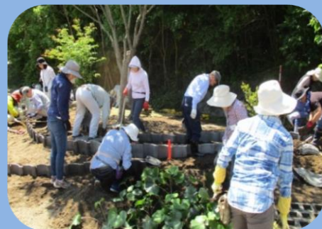
緑地施工実習
