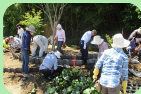
緑地施工実習
