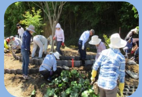
緑地施工実習
