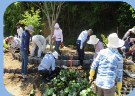
緑地施工実習
