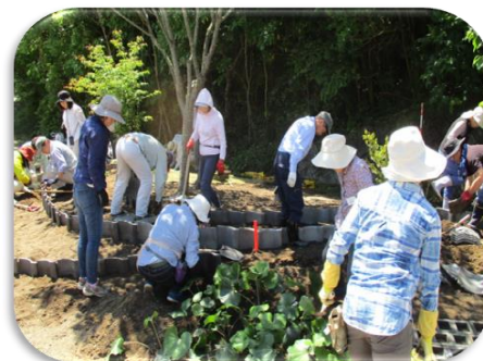
緑地施工実習
