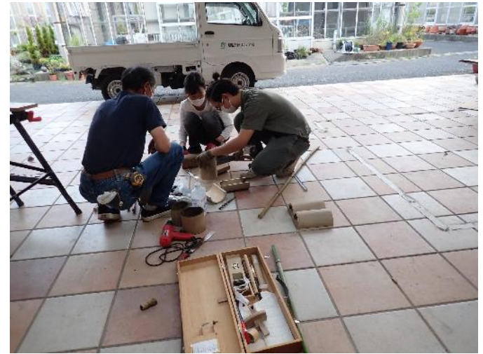
安定するように消毒液の容器のサイズに 合わせてモウソウチクを割る
