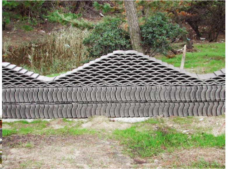
② 瓦を用いて50mに亘る塀を築いた
