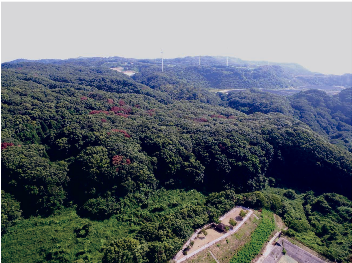
写真2 夕陽ヶ丘クリーンセンター南側山林の枯損状況2
