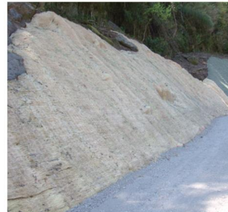
■大分県(法面緑化工事)
