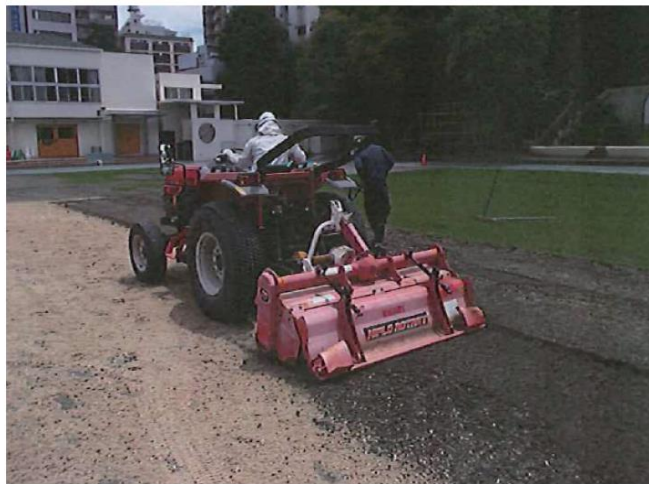
■東京都(校庭グラウンド芝生化工事)
