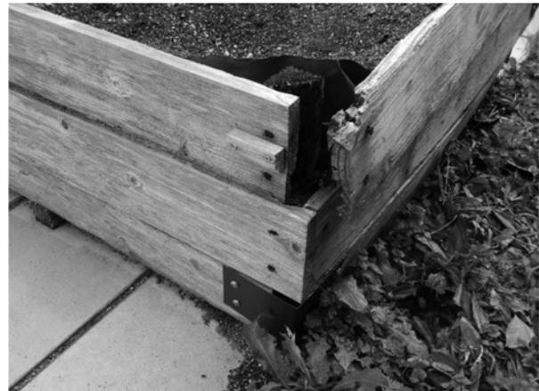
写真4 側板の部分的な軽度の腐朽（内部の柱材の腐朽によりビスが外れている）
