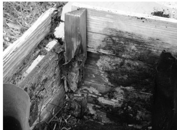
写真5 内部の柱材の激しい腐朽（柱材の腐朽によりビスが外れている）
